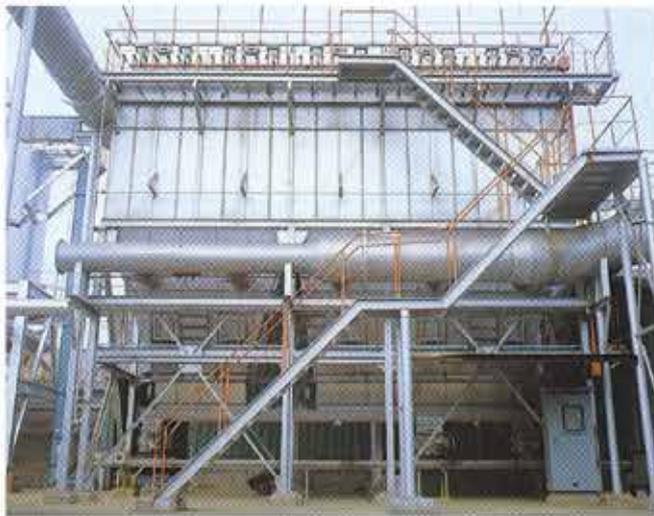
風量変動がなく高濃度ガスの集じんに最適です。中容量から大容量のものまで製作可能で、フィルタの取り替えは全機種とも機外上部から簡単に行える方式を採用しています。
