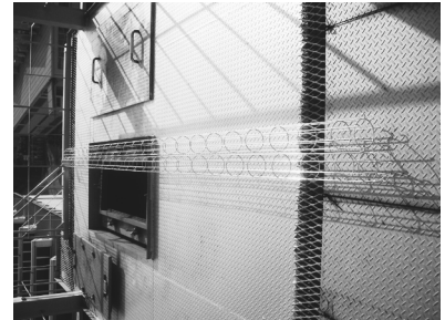
6 リテーナー上下段取り外し完了
