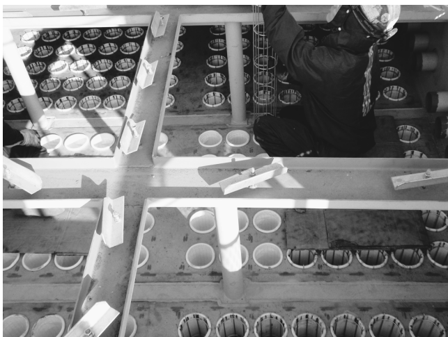
写真4 ろ布取り付け作業状況
